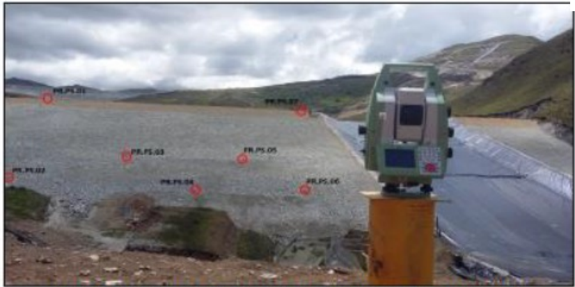
Ubicación de los prismas de monitoreo en Presa de Sedimentación
